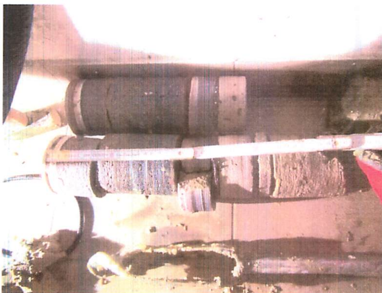
Fot. 19. Układ warstw posadzkowych w wykonanym odwiercie.
