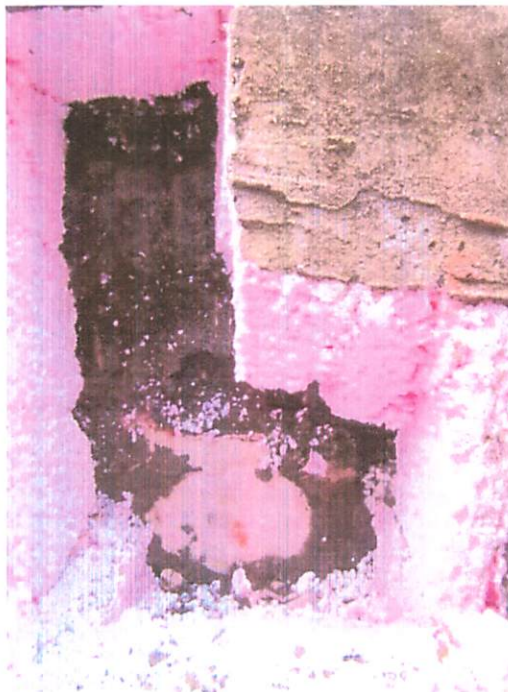
Fot. 26. Odkrywka ściany zewnętrznej w narożu budynku.
