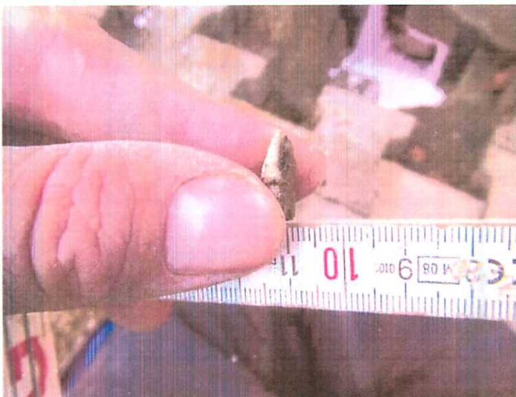
Fot. 28. Izolacja bitumiczna układana na zdegradowanym tynku o grubości poniżej 1 mm.
