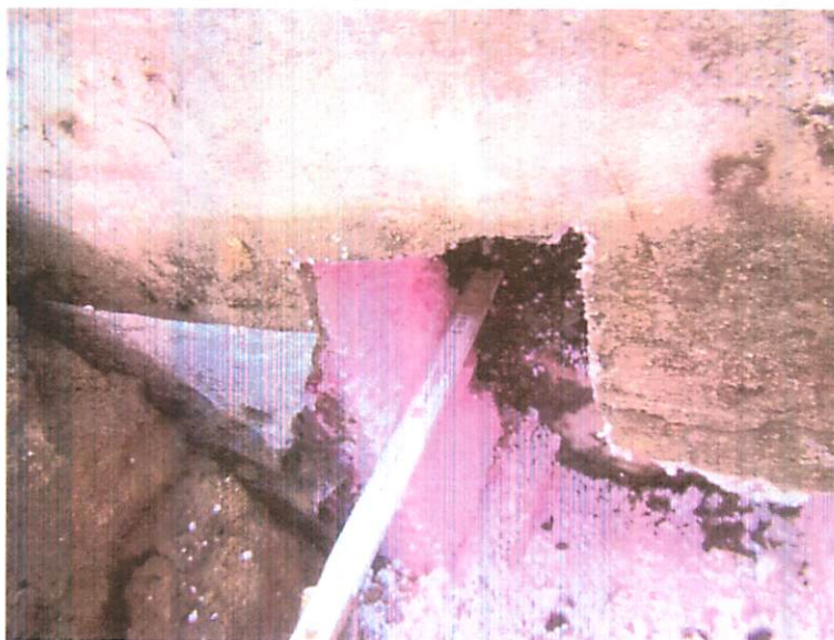
Fot. 27. Odkrywka. Styropian EPS różowy o grubości 10 cm.
