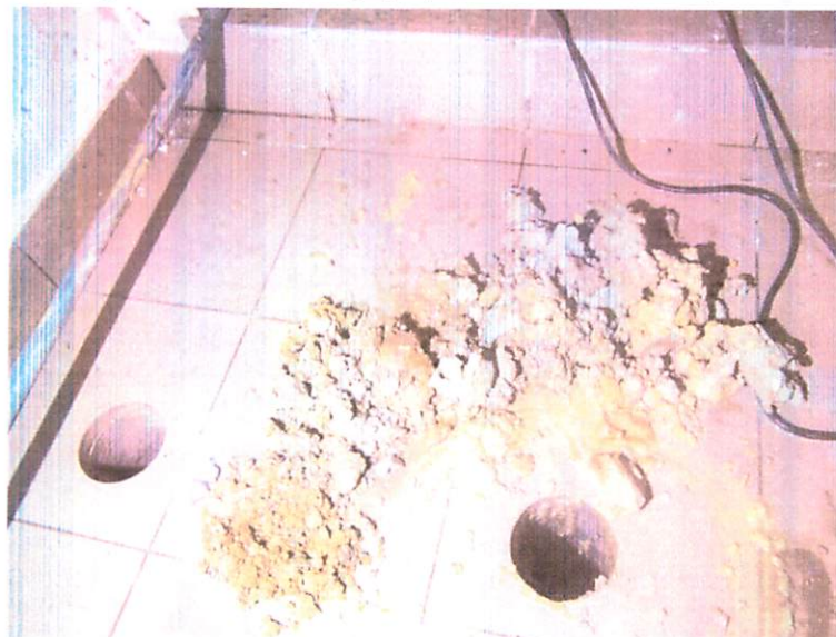
Fot. 21. Odwiert geologiczny pod posadzką.
