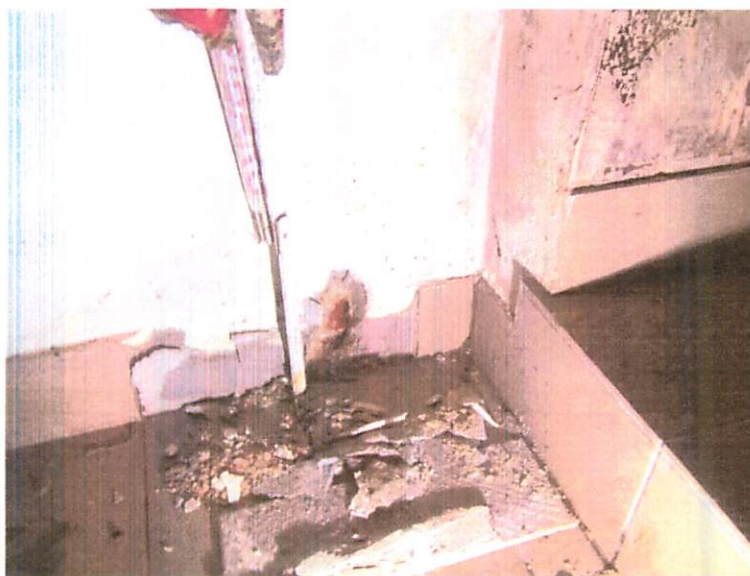
Fot. 24. Odkrywka ściany wewnętrznej w pomieszczeniu kotłowni.
