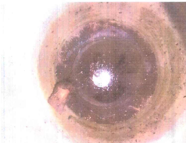
Fot. 15. Dno studni chłonnej. Odprowadzenie wody
