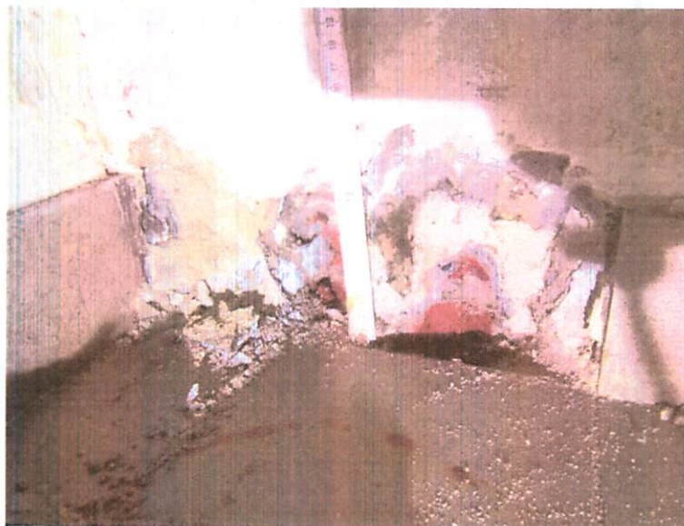
Fot. 23. Odkrywka ściany zewnętrznej w pomieszczeniu kotłowni.
