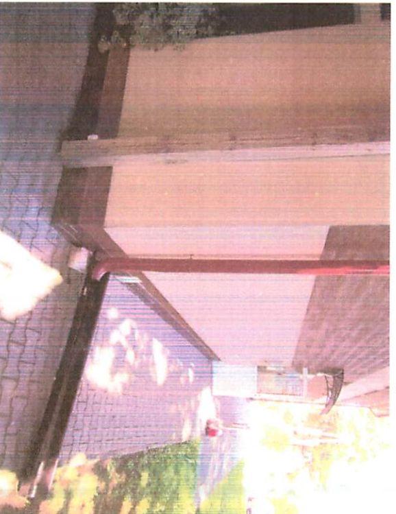
Fot. 2. Opaska z kostki wokół budynku.
