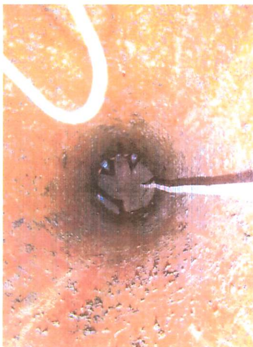
Fot. 14. Dno studzienki rewizyjnej drenażu. Dna na głębokości 2 m.
