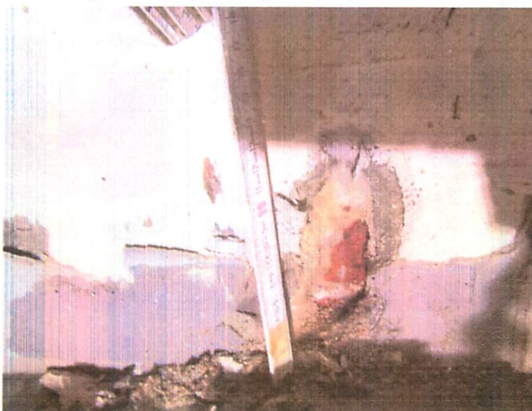
Fot. 25. Odkrywka ściany wewnętrznej w pomieszczeniu kotłowni.
